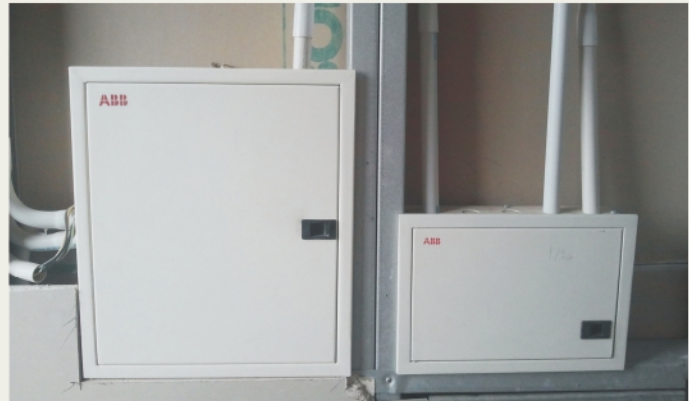
Conduit / MCB Box Fixing Arrangement
